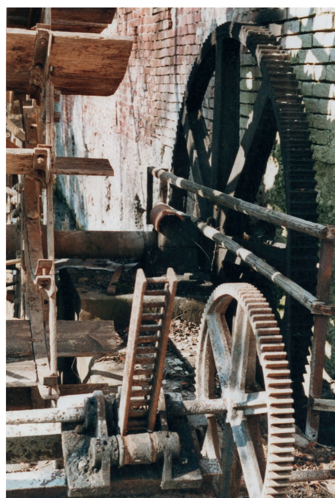
Getriebe des Wasserrads und Steuerung des Wasserzulaufs
