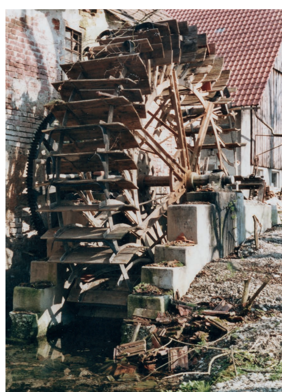
Unterschlächtiges Wasserrad von Nordwesten
