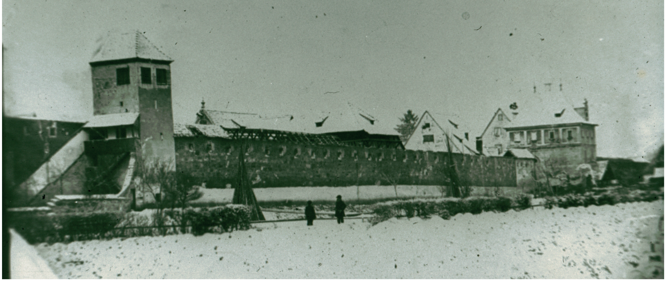
Stadtmauerpartie und Kalchtor vor dem Bau der Eisenbahn, Fotografie von Johannes Klotz, 1862 (Stadtarchiv Memmingen)
